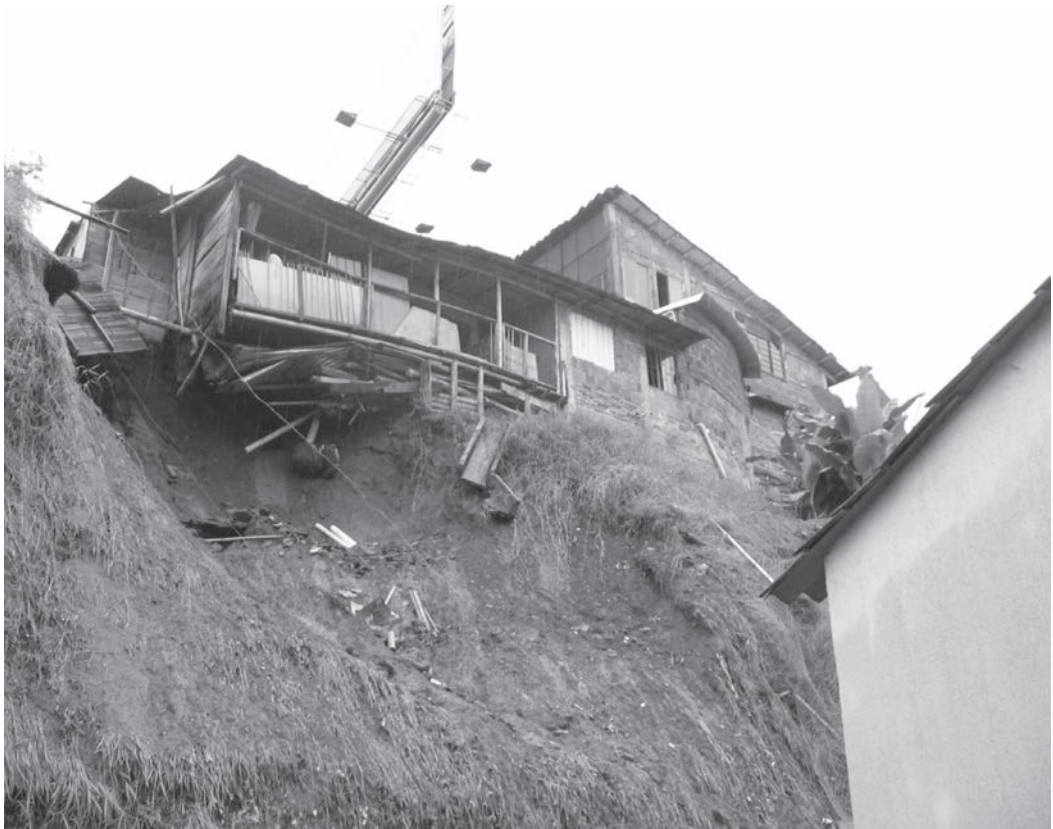
Figura 4. Inestabilidad de terrenos en Armenia (fotografía autorizada por OMPAD, 2006)
