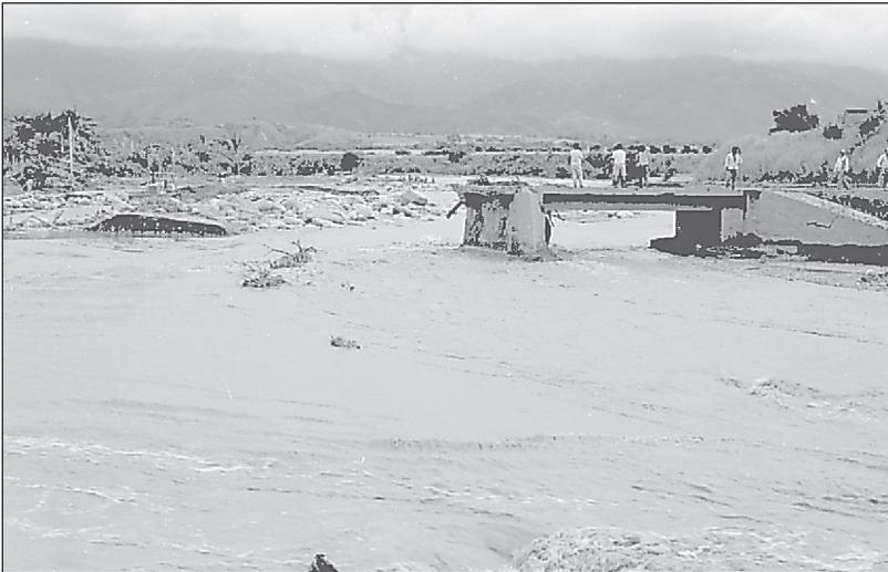
**Fig.11.9.** Puente destruido sobre el río Fraile, al sur de Florida, hacia el poblado de Miranda. Troncos y bloques se acumularon debajo del puente y provocaron su destrucción.
