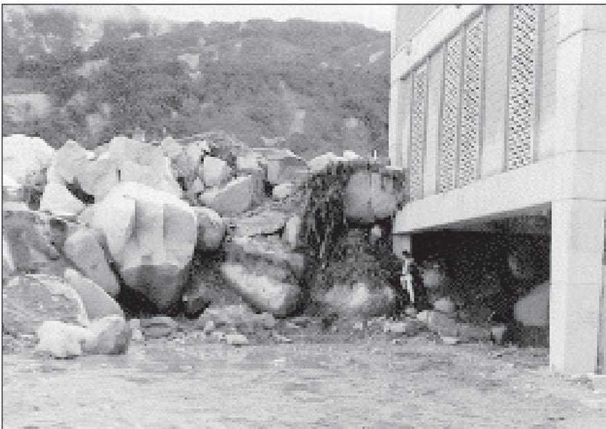
**Fig.7.9.** Detalle de bloques que afectaron la Casa de máquinas de Calderas. Los bloques ya habían comenzado a ser dinamitados y removidos. (Fotografía E. Velásquez).
