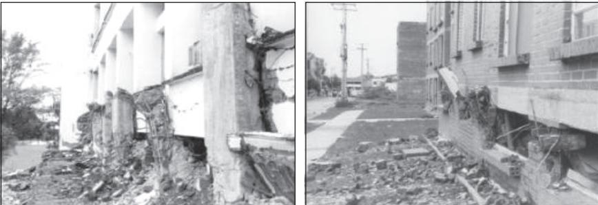
**Fig.3.3.** A la izquierda, edificio de la Facultad de Ingeniería de la Universidad del Cauca. Se observa un inadecuado confinamiento del núcleo de las columnas destruidas. A la derecha, daños muy severos en una versión inapropiada del concepto de mampostería estructural.
