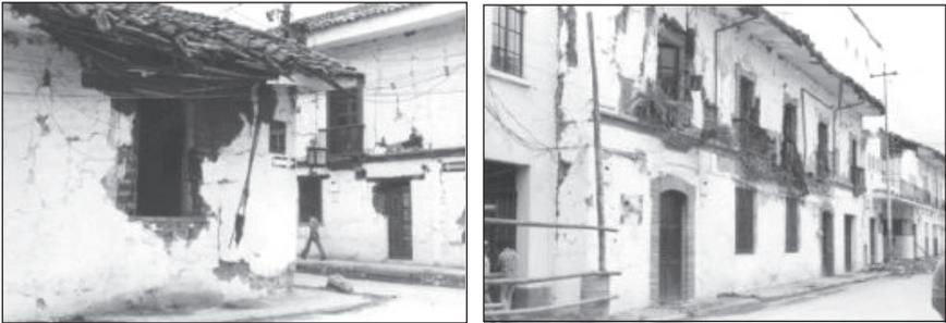
**Fig.3.2.** A la izquierda se aprecian los daños en una construcción de adobe localizada en esquina. A la derecha se muestran daños en una construcción construida en tapia pisada.
