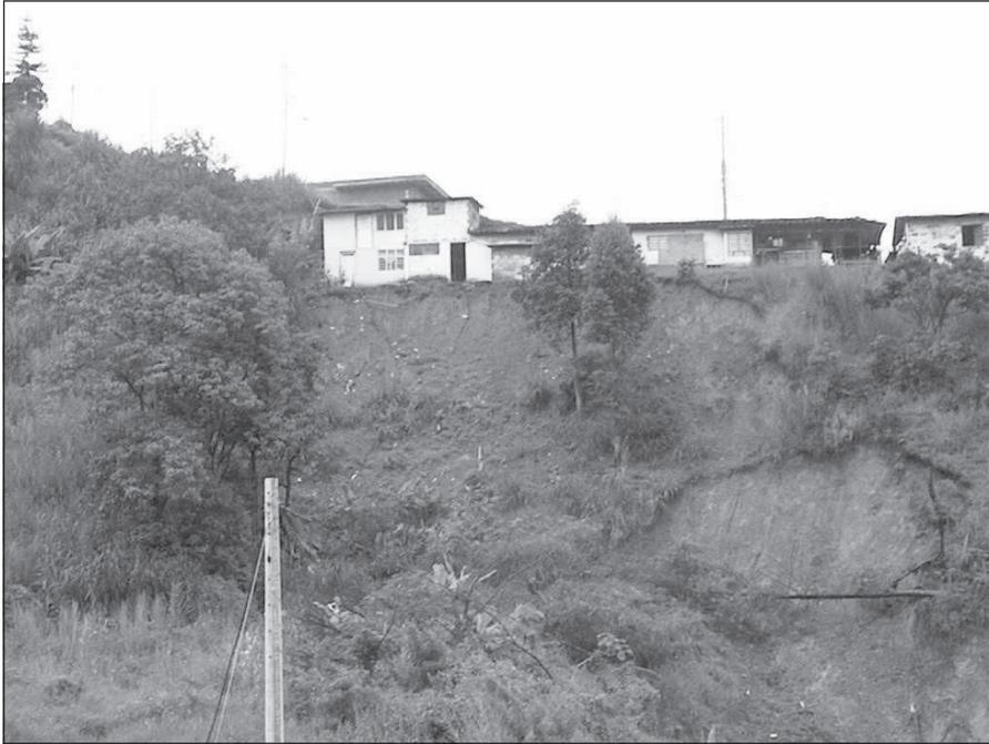
**Fig.15.10.** Deslizamientos sobre lleno artificial que afectaron viviendas (Sabaneta).
