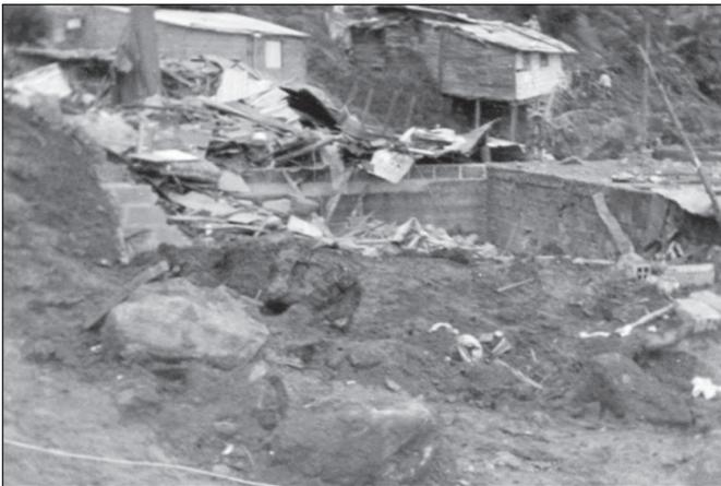
**Fig.5.7.** Casa destruida por deslizamiento. El empuje lateral de la masa que chocó contra la casa arrancó las paredes dejando sólo el piso (Foto Cárdenas & Ramos, 1988).
