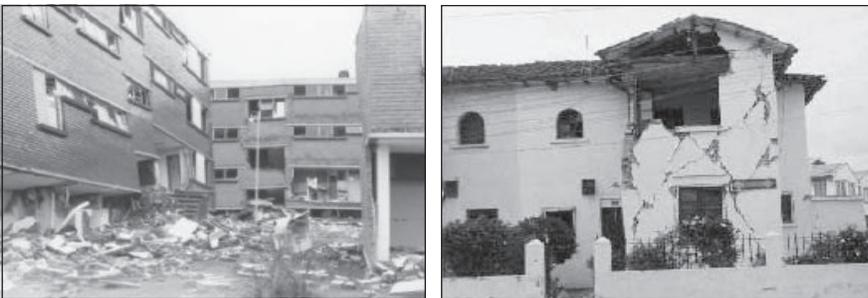
**Fig.3.4.** A la izquierda, destrucción de los edificios de la Urbanización Pubenza con columnas de sección insuficiente y armadura transversal escasa frente a los requisitos actuales. A la derecha, casas de ladrillo sin diseño para la resistencia a la acción sísmica.
